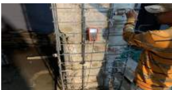
द्वारका, नई दिल्ली में एनएचएआई आवासीय एन्क्लेव के स्थल पर जिक एनोड की स्थापना के बाद निरंतरता परीक्षण किया जा रहा है
