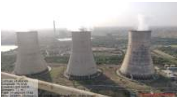
एपीसीपीएल झज्जर के आरसीसी एनडीसीटी कूलिंग टॉवर की स्थिति के आकलन का परियोजना स्थल
